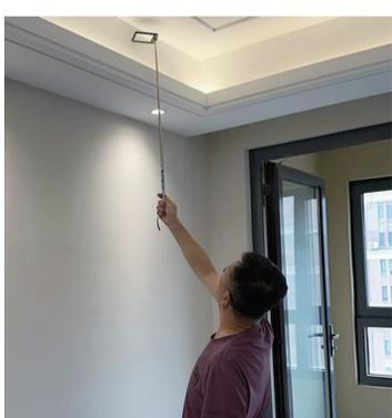
验房师用长柄反光镜检查吊顶内部。
