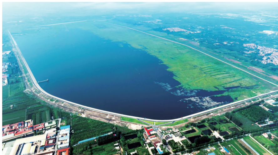
经过两年多的建设,宋化泉水库除险加固工程圆满完工蓄水。
