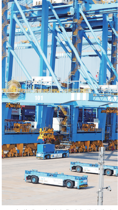
智慧港口实现全货种智慧化作业。
