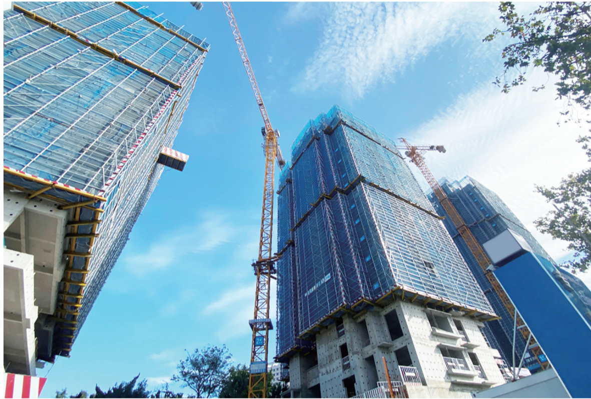
位于四流南路的在建楼盘。观海新闻/青岛早报记者 薛雅方 摄
