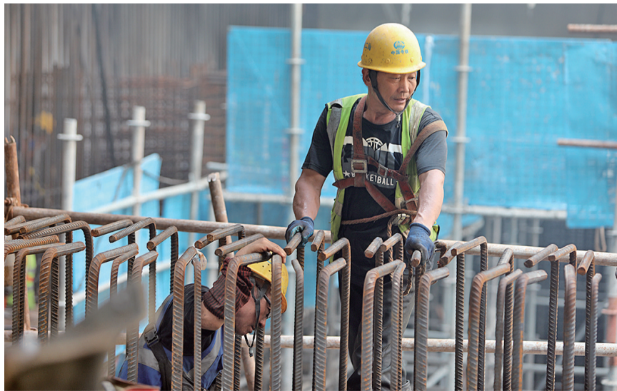
钢筋工在狭窄的空间里作业。
