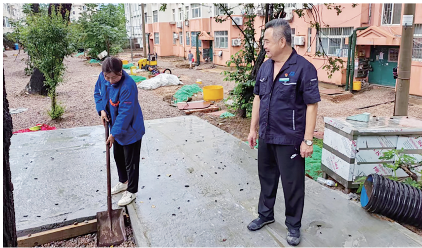
山东世纪物业对泥泞道路增设安全踏板,确保居民安全出行。
