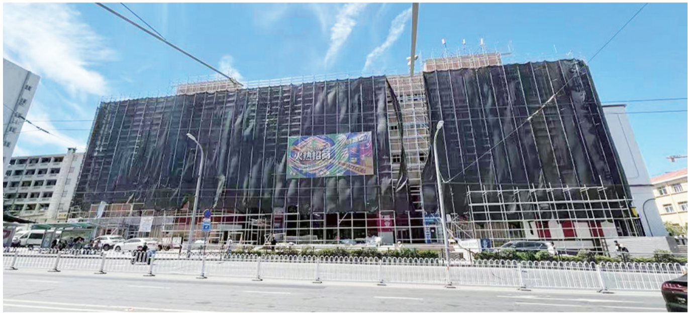
正在施工中的“台东UP·芒盒里”项目。
