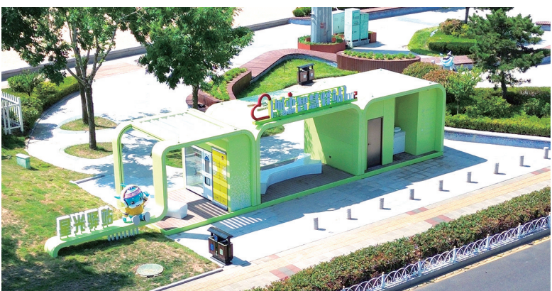
位于西海岸新区珊瑚贝桥东侧的星光驿站。西海岸公用事业集团供图
