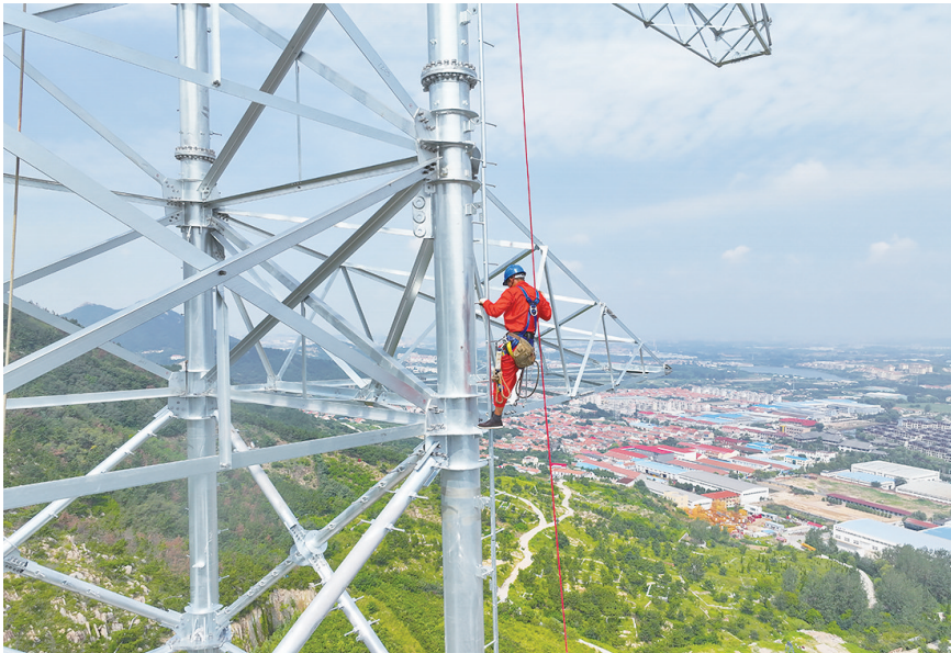
工作人员在铁塔组立完成后,开展螺栓紧固作业。
