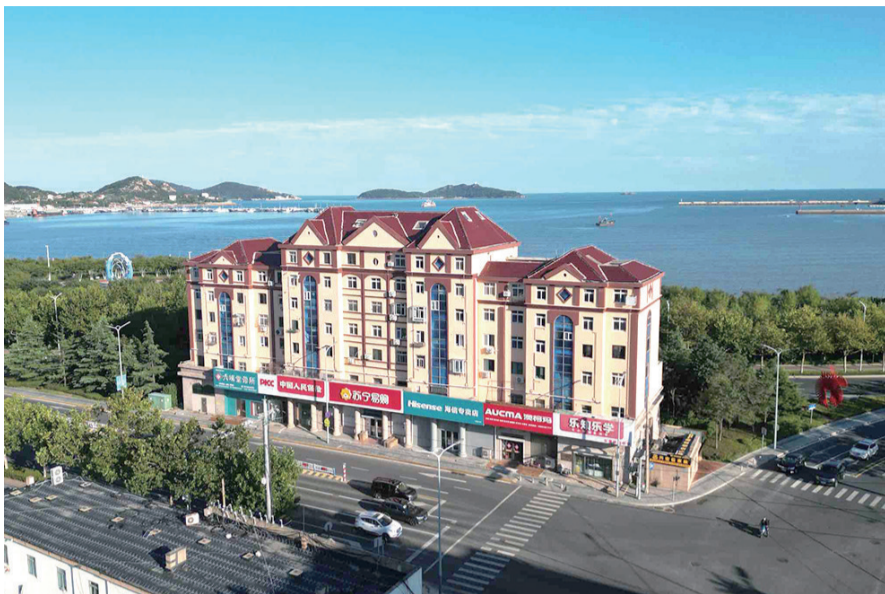
十字路商贸楼改造后效果。崂山区住建局供图
