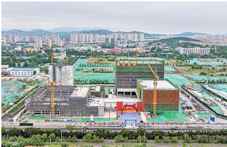
李沧区楼山创忆空间项目主体封顶。
