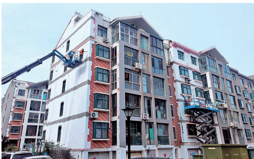
江南六期14号楼外墙保温加紧施工中。
