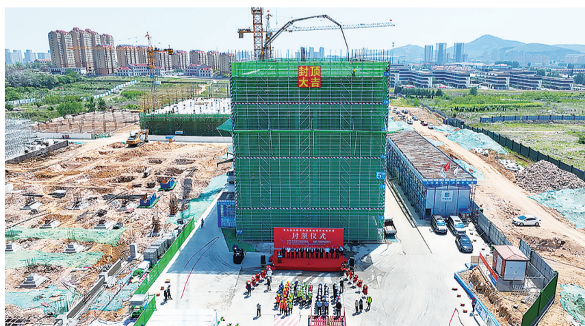
封顶仪式现场
