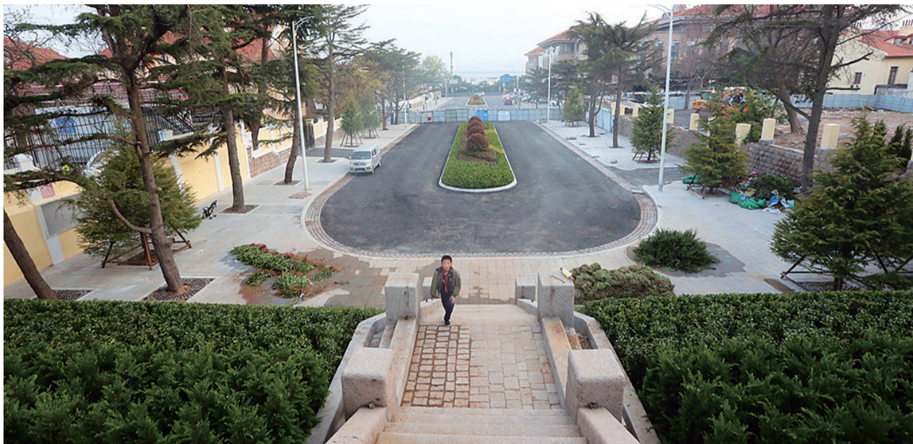
青岛路北段施工进入尾声。观海新闻/青岛早报记者 杨博文 摄
