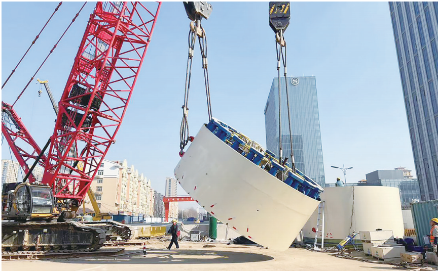
“铁龙七号”盾构机组装现场。地铁供图
