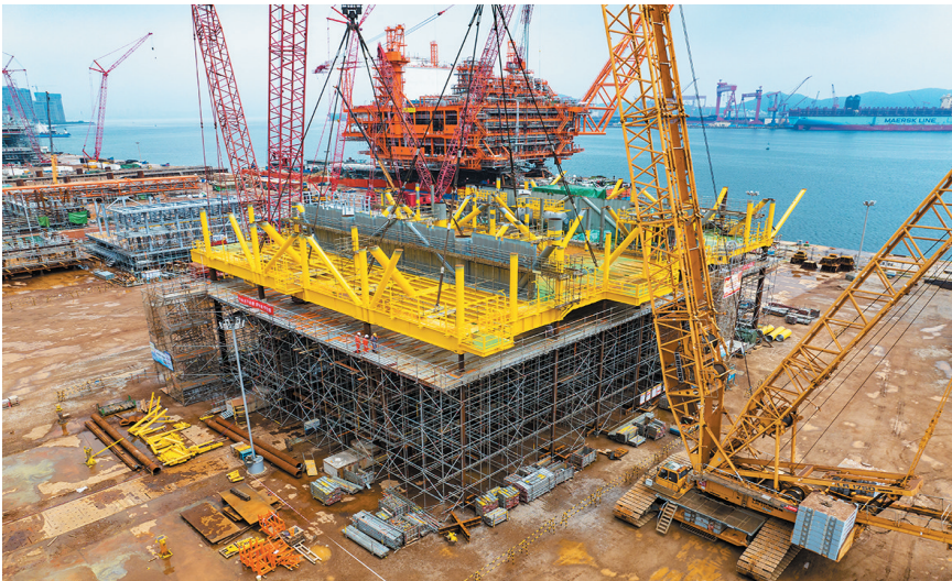
“深海一号”二期工程综合处理平台上部组块甲板片吊装。
