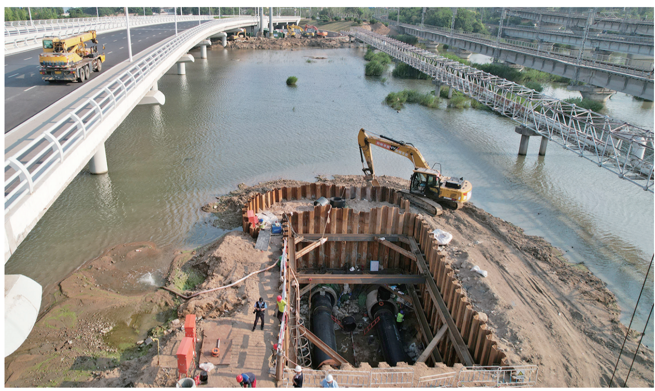
安顺路高温水管网李村河过河顶管接收坑施工中。
