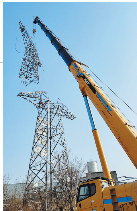
220kv高压线塔拆除。
