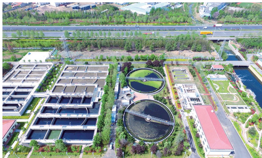
青岛即墨大任污水处理厂。青岛水务集团供图
