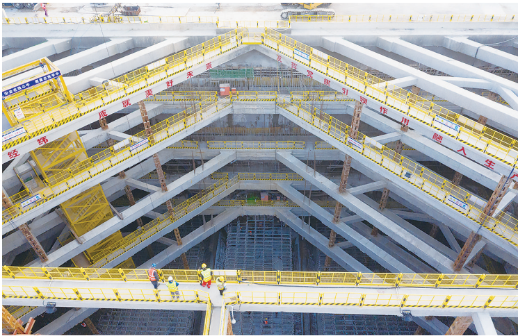
2月16日 膠州灣第二隧道青島端盾構始發井基坑在施工。
