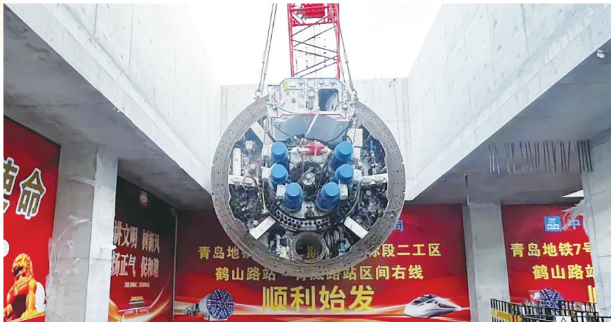
青岛地铁7号线二期工程鹤山路站至青威路区间右线盾构始发。
