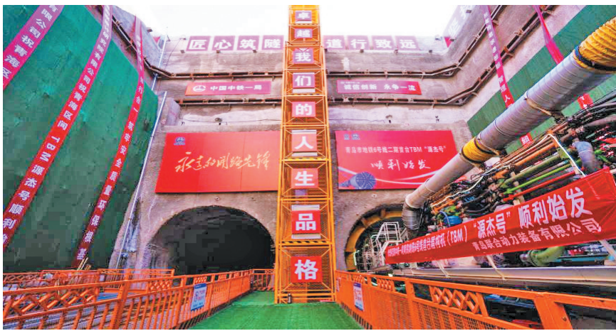
地铁6号线二期首台TBM始发。地铁供图
