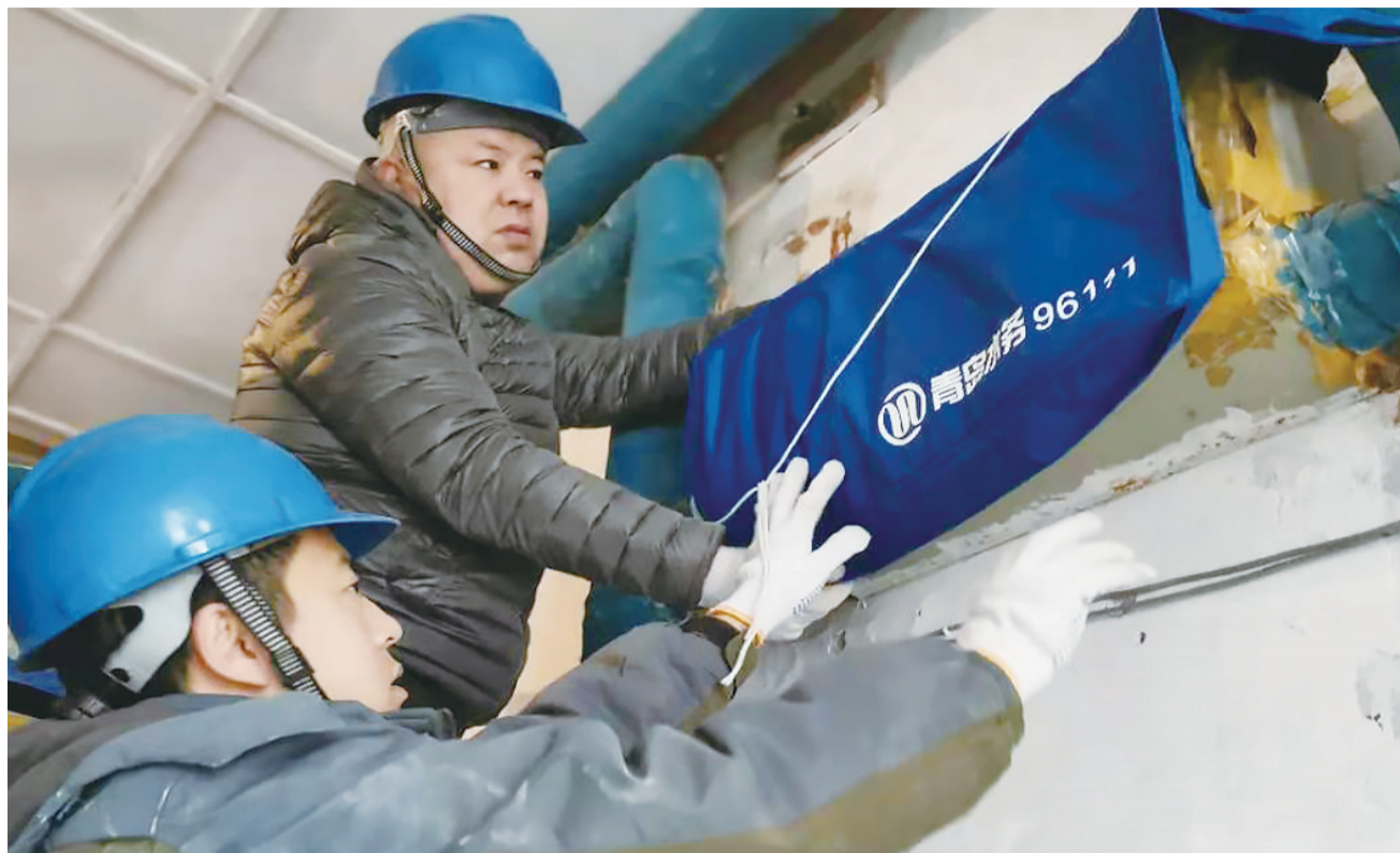
青岛水务海润自来水公司工作人员对供水设施进行防冻保暖作业。青岛水务集团供图
