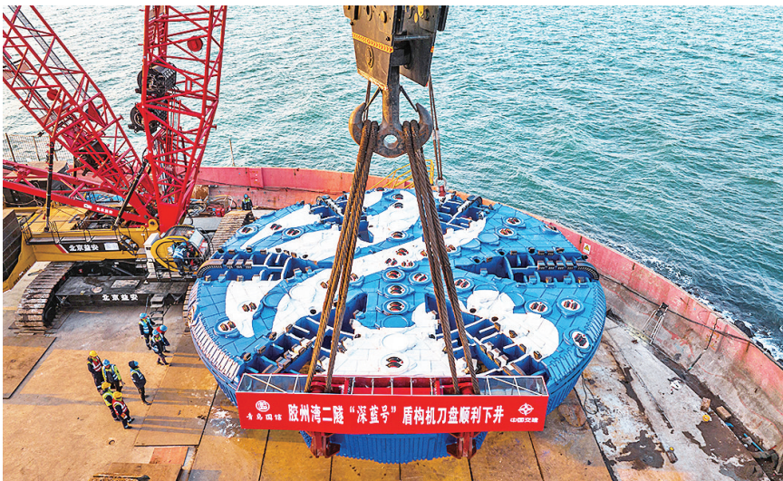
胶州湾第二隧道工程“深蓝号”盾构机刀盘下井。
