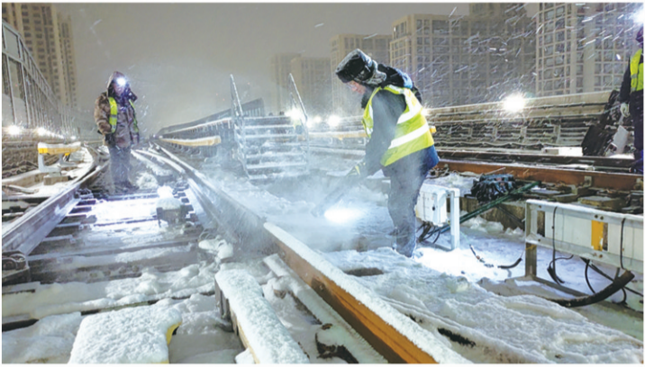
青岛地铁信号正线检修工深夜对正线道岔进行检修、除雪。
