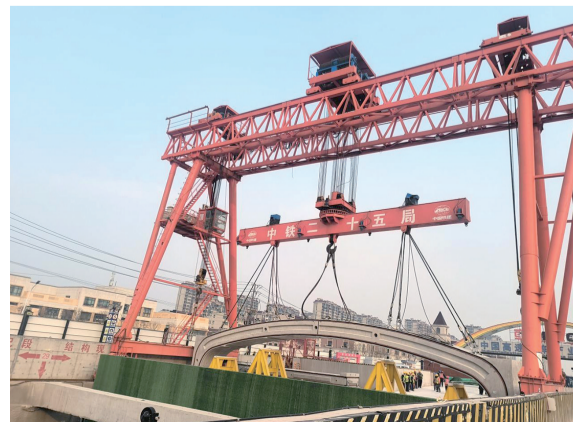
103吨大分块坦拱顶板构件进行吊装作业。青岛地铁供图
