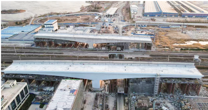
施工现场的两座钢筋混凝土预应力转体T构梁桥。
