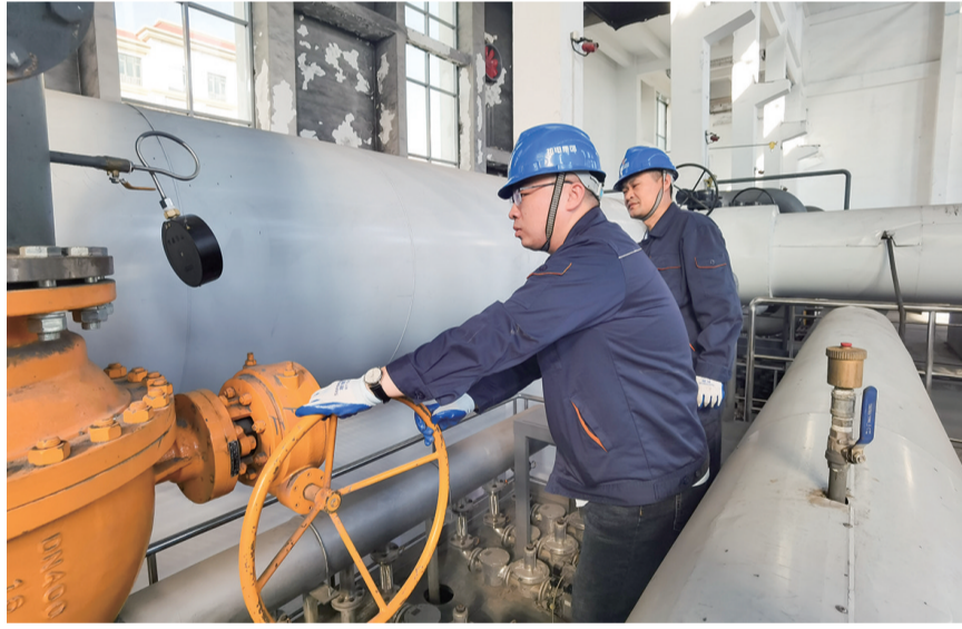
青岛能源热电集团麦岛供热站工作人员正在调试锅炉设备。
