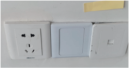
相邻插座盖叠落在一起，四周缝隙明显。
