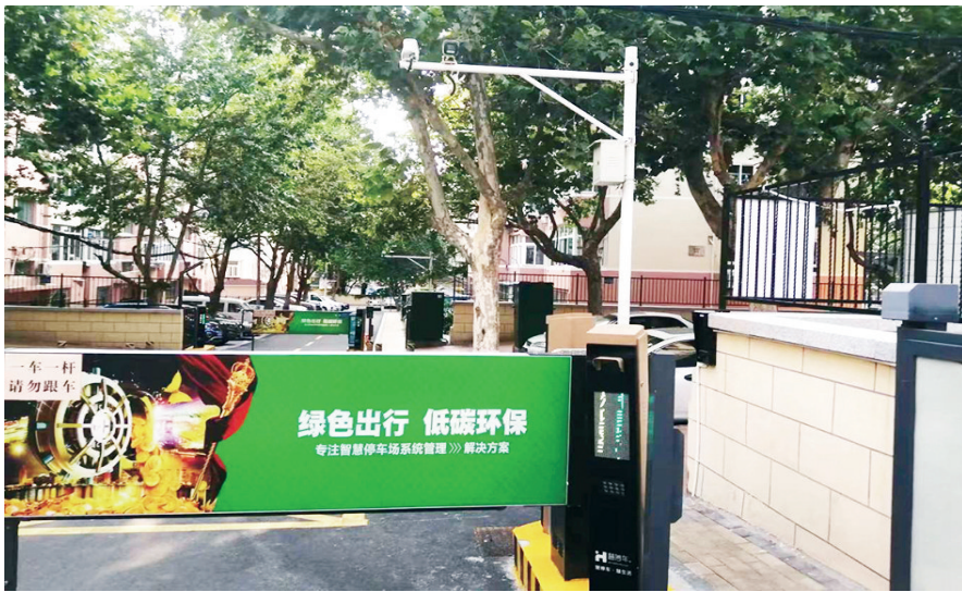
老旧小区出入口安装人脸识别及车行道闸识别系统。
