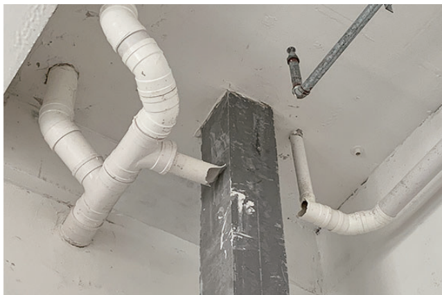
卫生间下水管破碎未连接。
