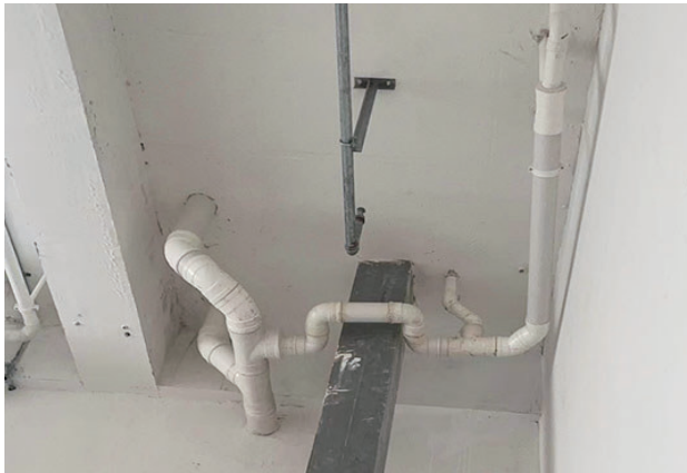
卫生间下水管破损处已修复。
