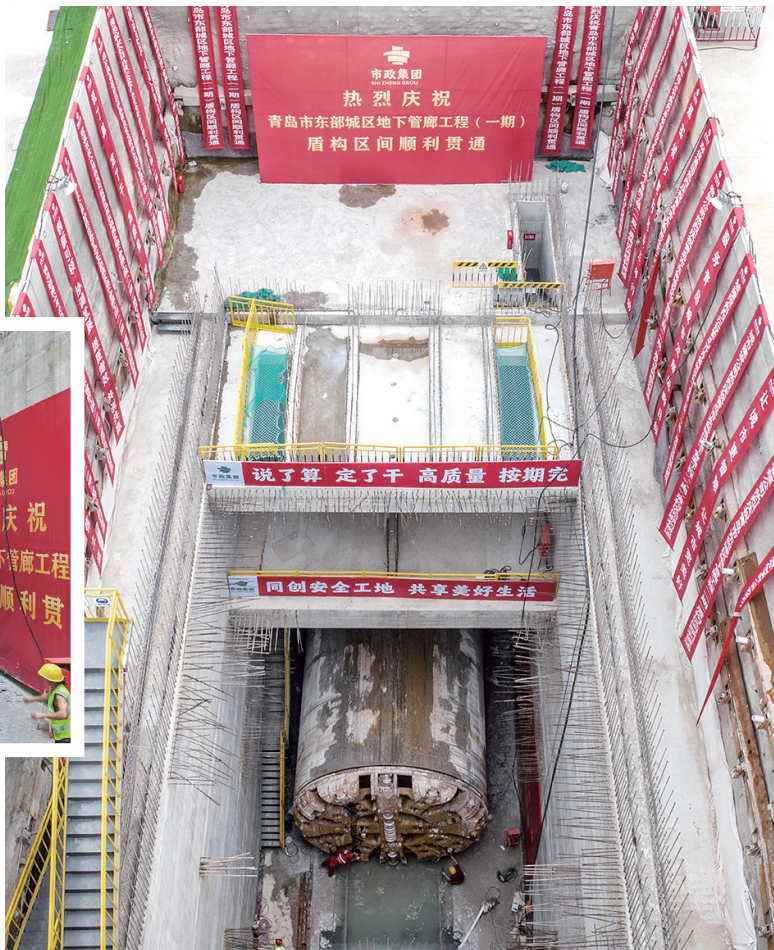
▲施工现场的“市政铁军2号”盾构机。 施工方供图 ►东部城区地下管廊工程(一期)盾构区间顺利贯通。 观海新闻/青报全媒体记者 刘栋 摄
