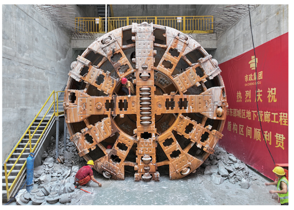
▲施工现场的“市政铁军2号”盾构机。 施工方供图 ►东部城区地下管廊工程(一期)盾构区间顺利贯通。 观海新闻/青报全媒体记者 刘栋 摄
