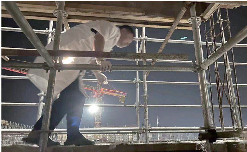
姜子超行走在工地脚手架上靠近伤者。视频截图
