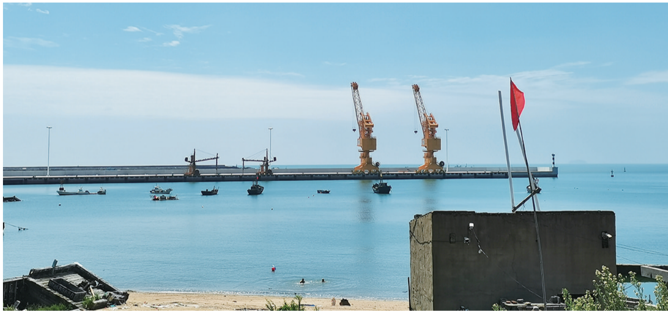
升级改造完工的女岛港。
