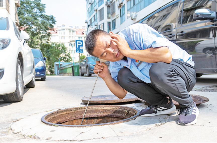
检修人员正在用听针测漏法进行听测排查。企业供图
