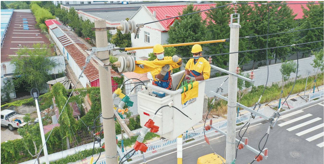
即墨区供电公司工作人员全副武装进行空中带电作业。
