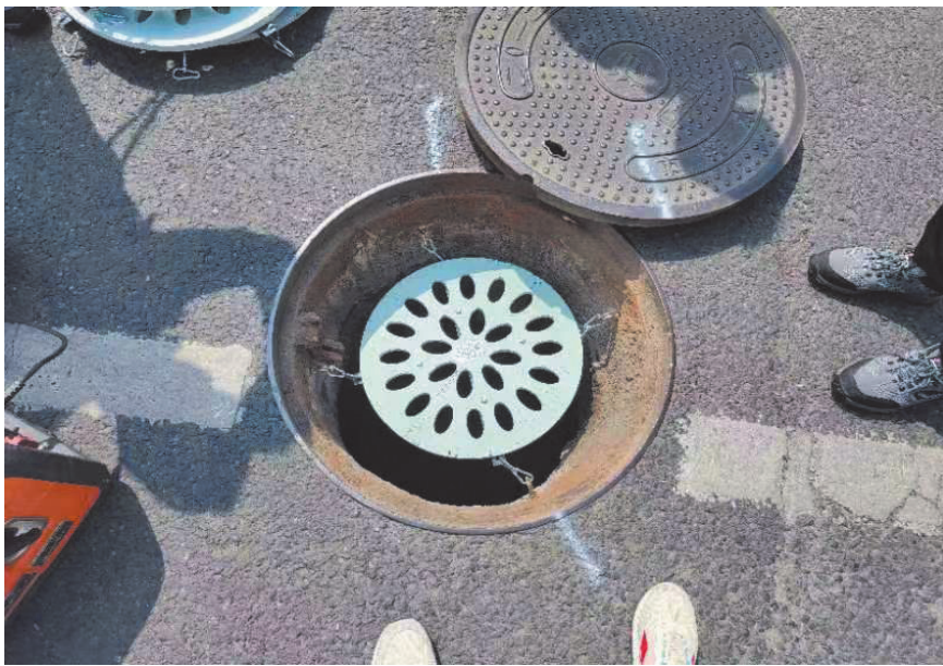
已装上防坠隔板的窨井。青岛水务排水公司供图
