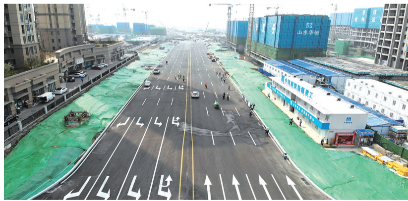
合肥路(科技园八路—松岭路)实现主线贯通。
