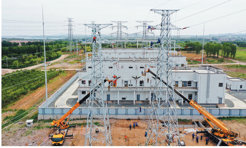
220千伏蒲渠站配出工程正式建成送电。
