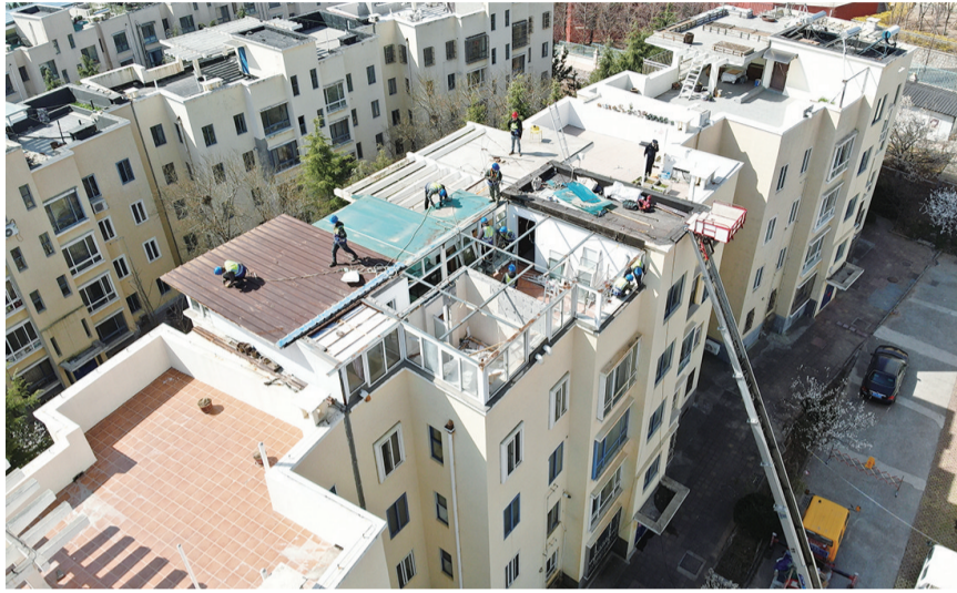
对小区楼顶违建房进行拆除。
