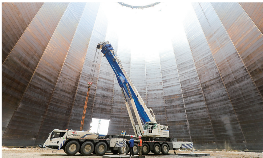
大尧气柜内部拆除作业。
