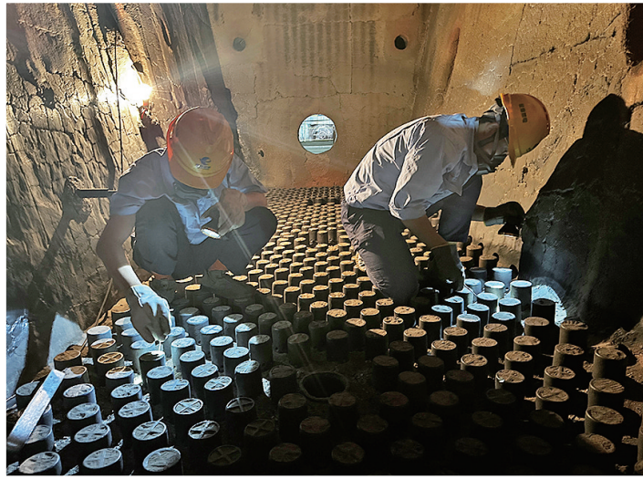
工作人员清理循环流化床锅炉风帽。
