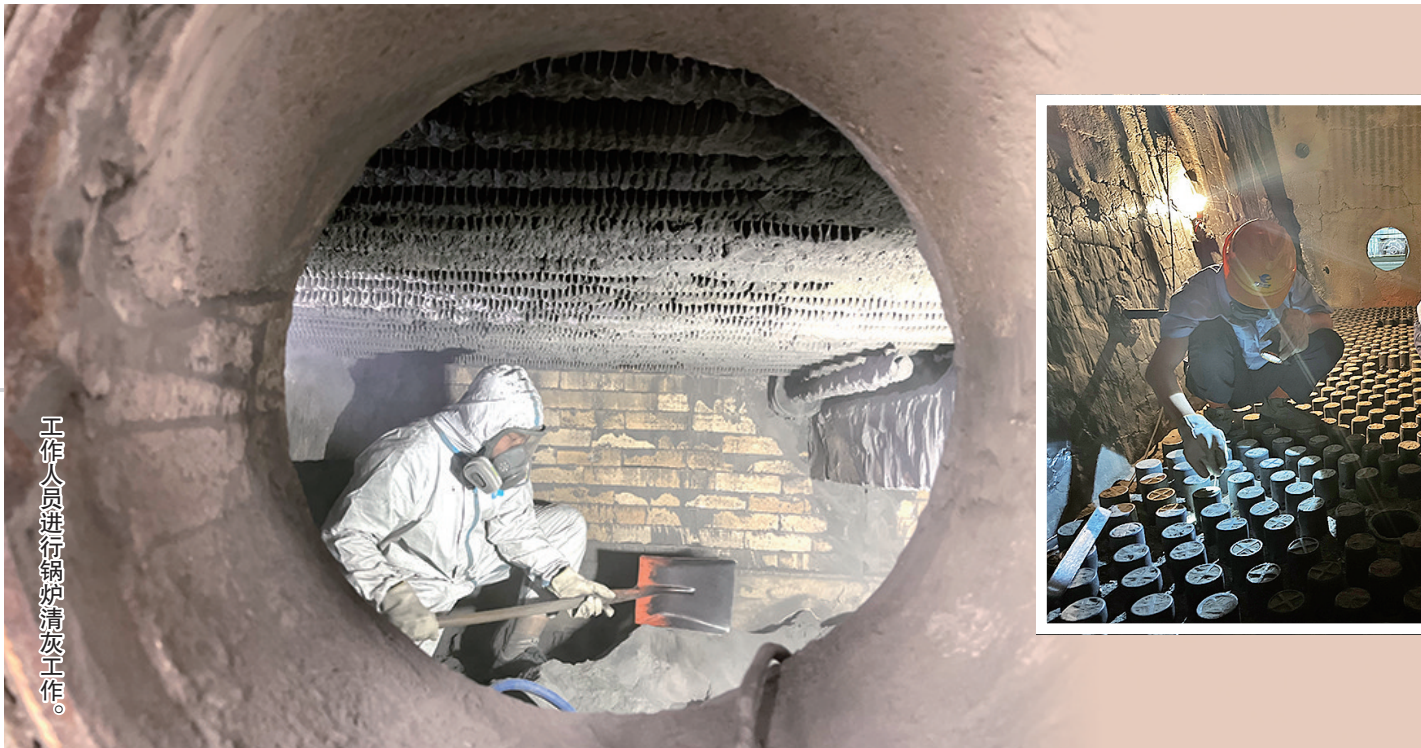
工作人员清理循环流化床锅炉风帽。
