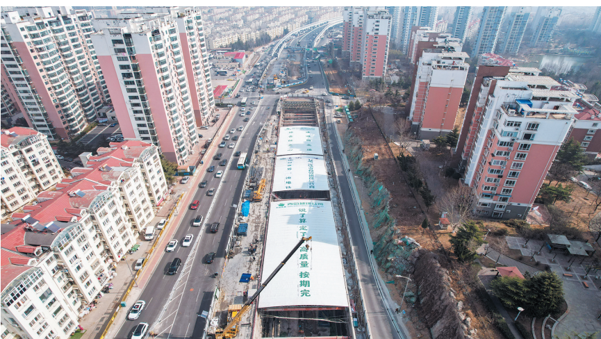
辽阳西路快速路地道基坑覆盖移动天幕防扬尘。观海新闻/青岛早报记者 魏妮邦 摄
