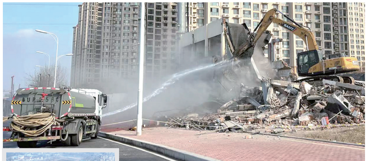
拆除网点房的同时,洒水车洒水降尘。
