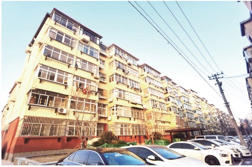
四机宿舍小区样板段已基本完成改造。
