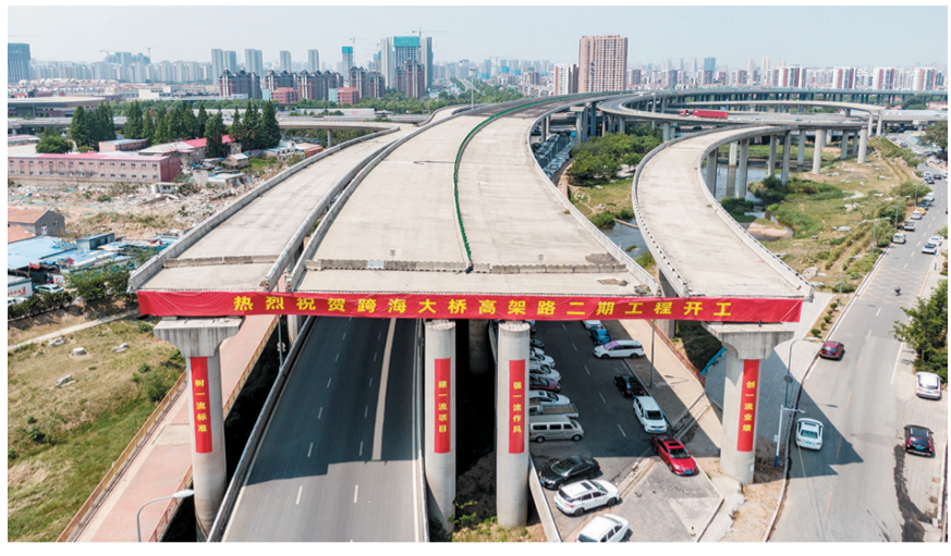
跨海大桥连接线二期工程。 观海新闻/青报全媒体记者 刘栋 摄
