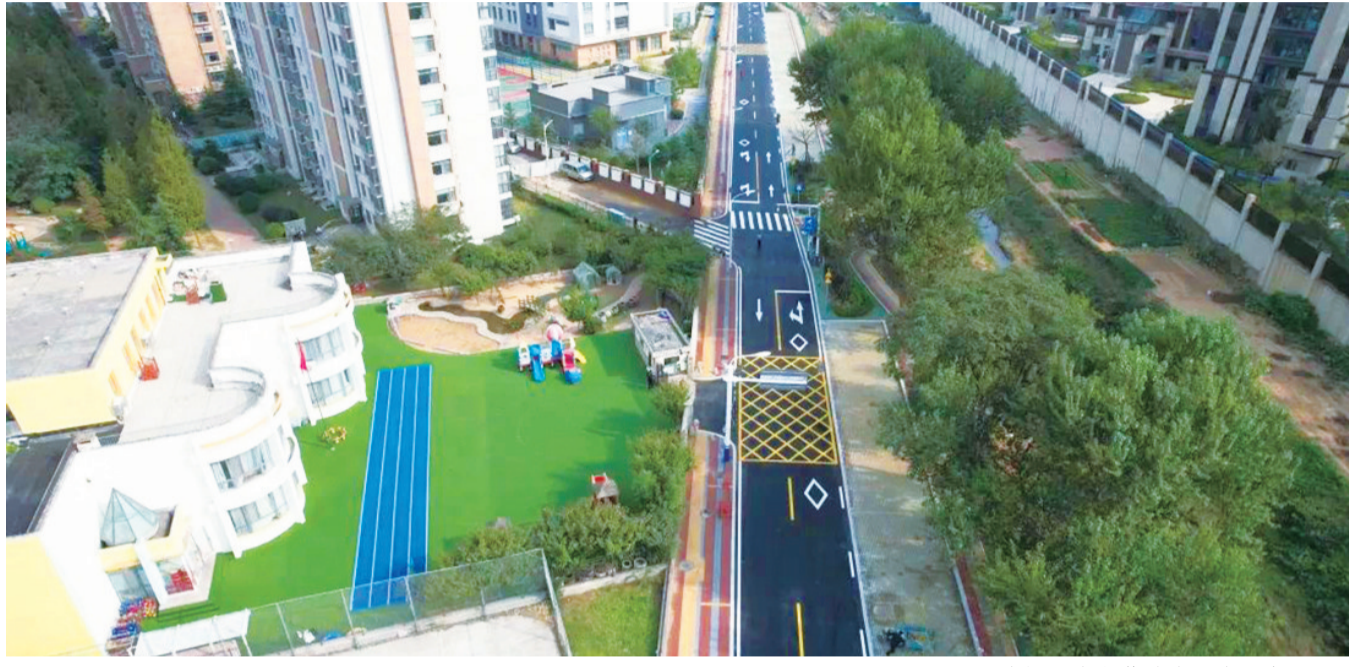
峨眉山路小学道路周边配套工程。
