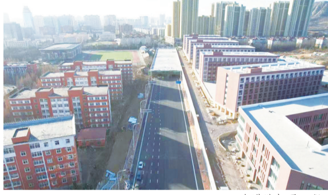
奋进路打通工程。
