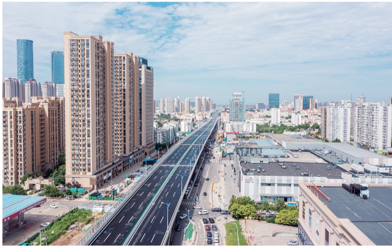
杭鞍高架二期工程提前实现主线通车。 观海新闻/青报全媒体记者 刘栋 摄
