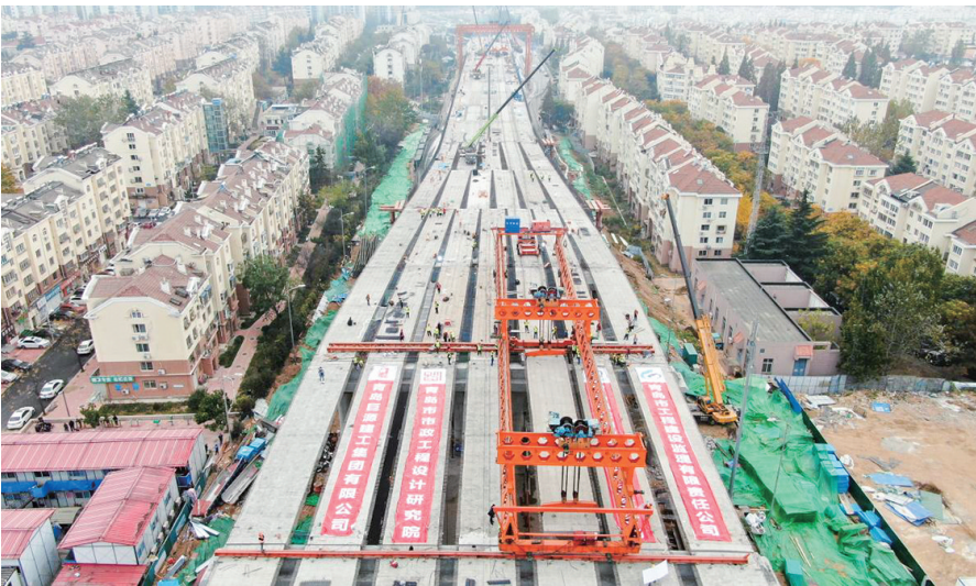
辽阳路快速路主桥上部结构全部架设完成。
