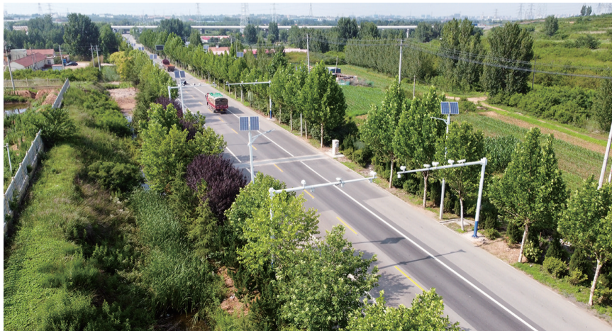
胶州完成53条“四好农村路”建设。
